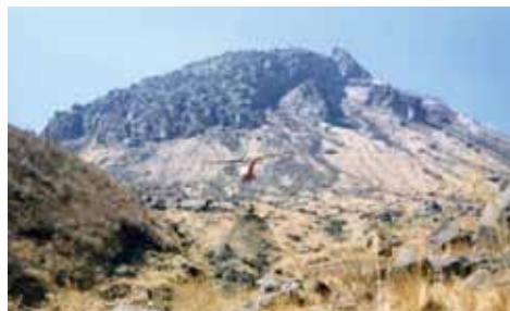
航空緑化工施工の様子
