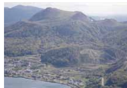
洞爺湖町付近の復旧状況(平成23年)
