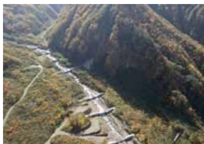
平成13年から平成29年にかけて整備した治山ダム群
