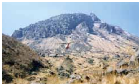
航空緑化工施工の様子
