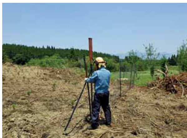
鹿ネット 施工中
