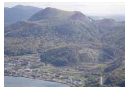
洞爺湖町付近の復旧状況(平成23年)
