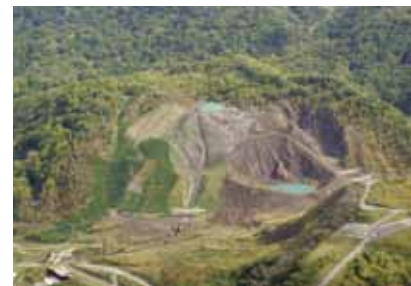
整備した治山ダム群及び山腹工(平成19年)
