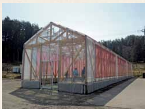
写真2 地域材を活用した農業用温室
