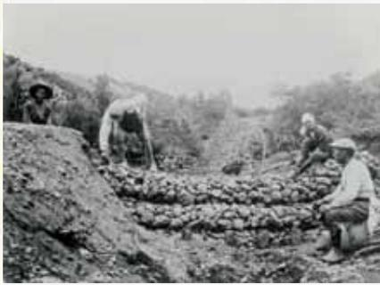
鉄線蛇籠堰堤の設置工事
