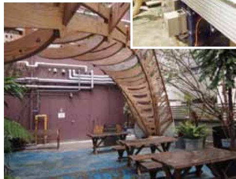
◀ Shopbot を用いて製作した仮設橋
