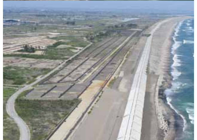
東日本大震災による被災直後の状況（上）と植生基盤造成の状況（下・左側）
