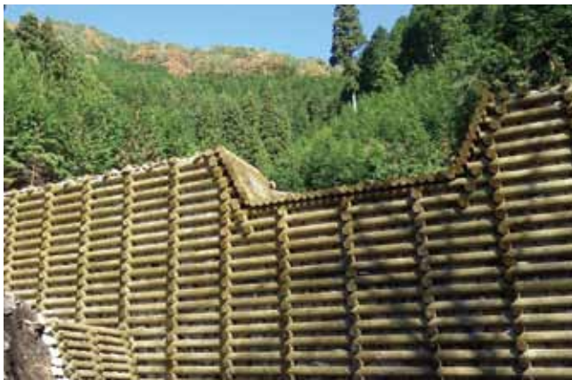
間伐材を使用した治山工事
