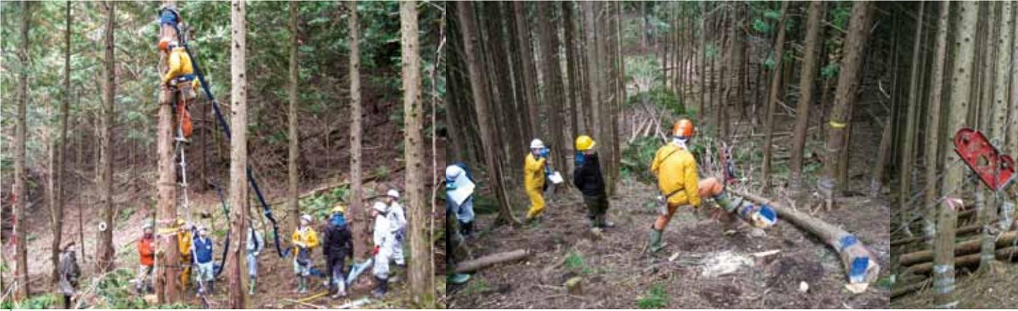
高性能林業機械作業システム（生産性）研修の様です。写真右からスイングヤードの設置状況、中央が架線下の集材木の状況、左が先柱の状況です。ここでは、スイングヤードを使用した集材のデータ収集を行い、生産性の算出等を通して、ボトルネックがどこにあるのか、改善すべきポイントはどこかなどを検討し、効果的で効率的な作業システムの基礎知識を学習します。
