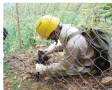
シカ防護柵設置実習
