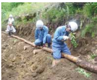
作業路作設実習
