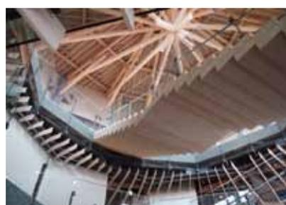
浮遊感のある木の階段。階段も鉄骨を下地に、パズルのように木を組み込んでいる。
