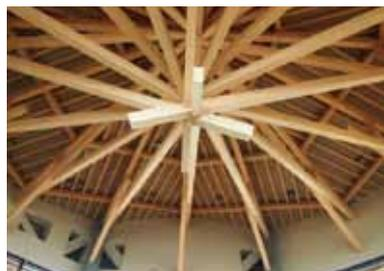
建物に入り上を見上げると、木材(ヒノキ製材)と鉄骨を組み合わせて組まれた、美しい木架構の天井が見える。
