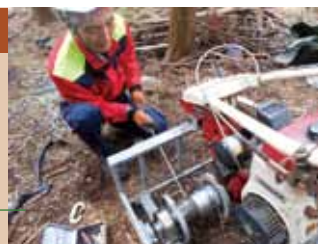
溝切り機等を改造したロープウインチ
