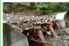
(参考)流木捕捉式治山ダムによる土石・流木捕捉の例
