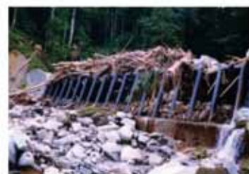
流木捕捉式治山ダムの設置
