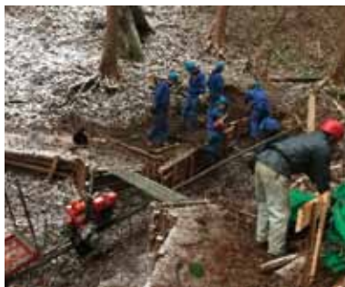
モノレールの設置作業
