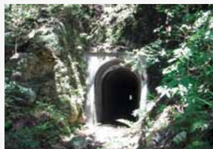
写真8 森林軌道のトンネル跡
