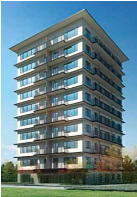
▲賃貸マンション（宮城県仙台市、10階建て鉄骨造（一部木造）、延べ面積3,605㎡、2019年2月竣工予定）
