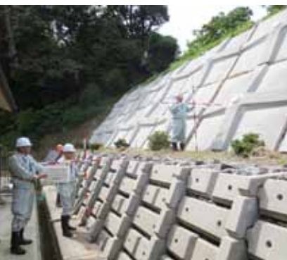
山地防災ヘルパーによる治山施設点検 (石川県珠洲市)
