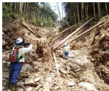
職員を派遣し災害箇所を調査 (平成29年7月九州北部豪雨：福岡県朝倉市)
