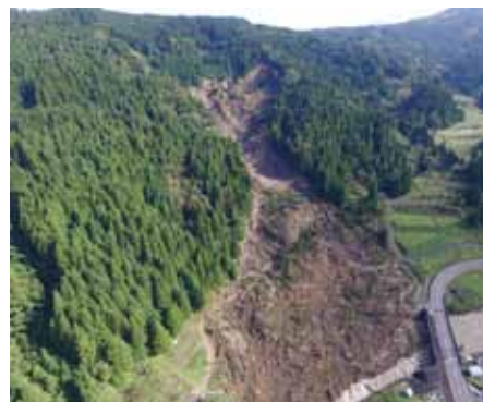
平成29年10月台風21号により山腹崩壊が発生 (新潟県糸魚川市)
