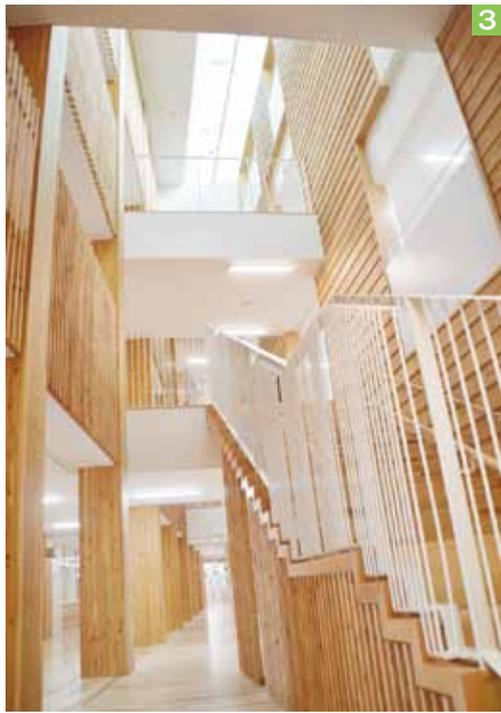
材「燃エンウッド」を使用。燃エンウッドは、「荷重支持部」と呼ばれる木の構造体と「燃え止まり層」、「燃え代層」からなる耐火被覆層で構成されており、万が一火災が発生した場合には最外層の「燃え代層」のみが燃焼・炭化することで内部の温度上昇を抑制するとともに、「燃え止まり層」に配置されたモルタルで熱を吸収することで燃焼を停止させ、部材の中心部にある「荷重支持部」を火災から保護します。また、鉄筋コンクリート造の架構部分が木架構部分を含む建物全体の耐震性を確保する仕組みになっています。
