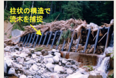
流木捕捉式治山ダム
