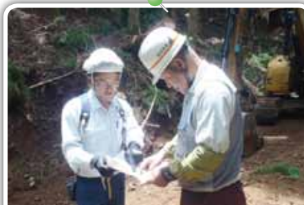
事業現場での作業指示
