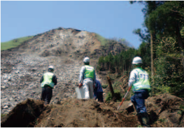
私有林被害箇所の現地調査（阿蘇市狩尾）
