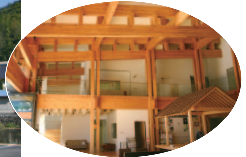
木材をふんだんに使用した2層吹き抜けのアトリウム
