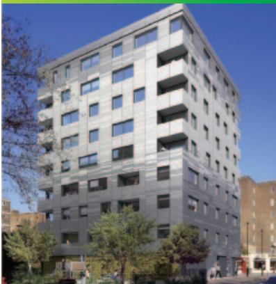
9階建てマンション(ロンドン)
