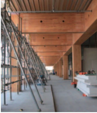
施工中のサウスウッド
