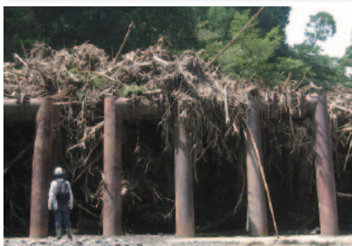
【写真 - 7】流木等を捕捉した治山えん堤(阿蘇地区)
