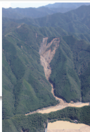
奈良県吉野郡十津川村の山腹崩壊
