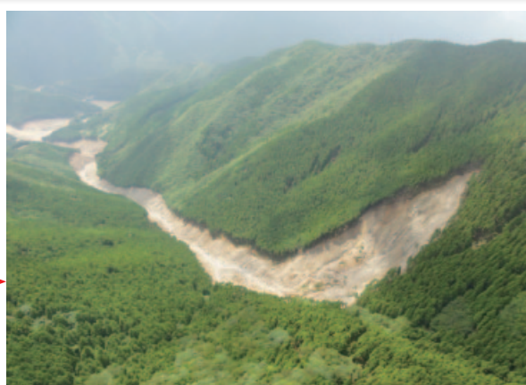
上流の山腹崩壊の状況
