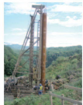
杭工の施工
