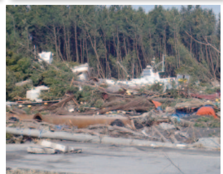
写真・1① 東日本大震災の津波により被災した海岸防災林（青森県八戸市）
