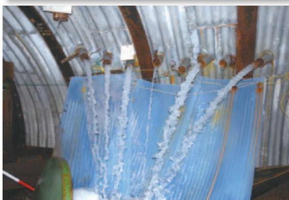
【写真・4】排水トンネルによる地下水排除の状況(磐井川地区)
