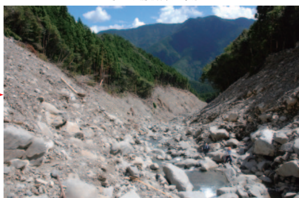
土石流による被災状況
