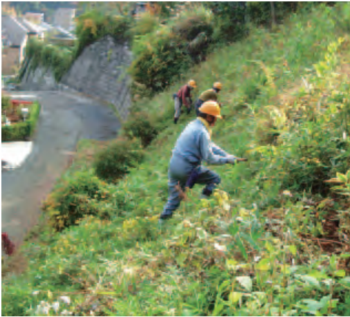
法面の草刈り
