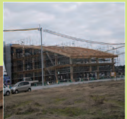
九州の木造公共建築物の例 (上天草市松島庁舎兼保健センター) 全景
