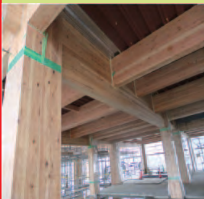
九州の木造公共建築物の例 (上天草市松島庁舎兼保健センター) 近景内部
