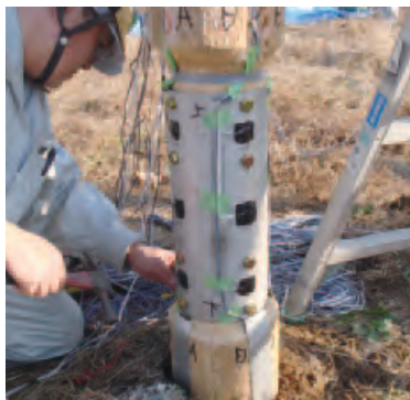
接合間伐杭の打設試験の様子
