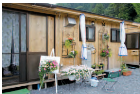
地域材を活用した木造仮設住宅。
