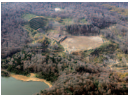
地すべり対策施工後の様子
