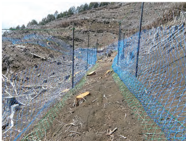
写真3 シカの通り道を用意した「ブロックディフェンス」
