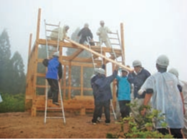
高知工高校建築科の生徒による展望台建築
