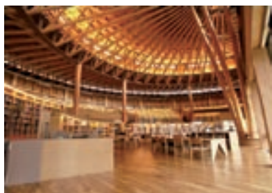
公立大学法人国際教養大学図書館（秋田県秋田市）／木造架構にはすべて秋田杉を使用し、伝統技術を活かした傘型屋根となっています。
