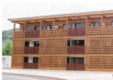
木造3階建て公営住宅（山口県美祢市）／「長期耐用型木造公営住宅」として、高性能耐力壁や格子状耐力壁を採用しています。
