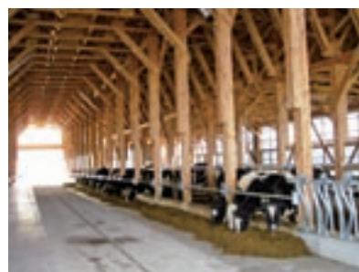
木造牛舎（北海道紋別市）／市内の森林認証されたカラマツを使用し、鉄骨牛舎に比べ吸音性・耐腐食性（耐塩性・耐アンモニア）などに優れています。
