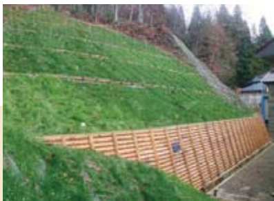
残存型柵（土留工）＜写真④＞
