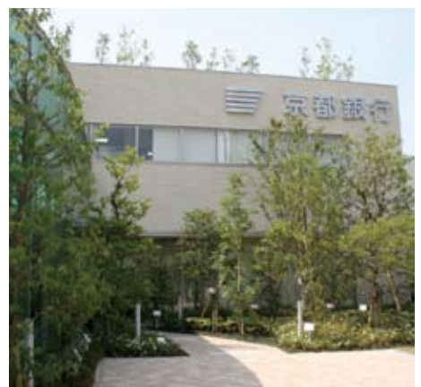
緑地帯に囲まれた建物
