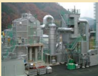
発電施設の改良
