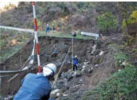
写真3 宮城県登米市における被災林道の測量
