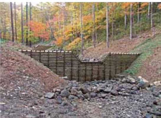
写真4 間伐材を使用した治山ダム
