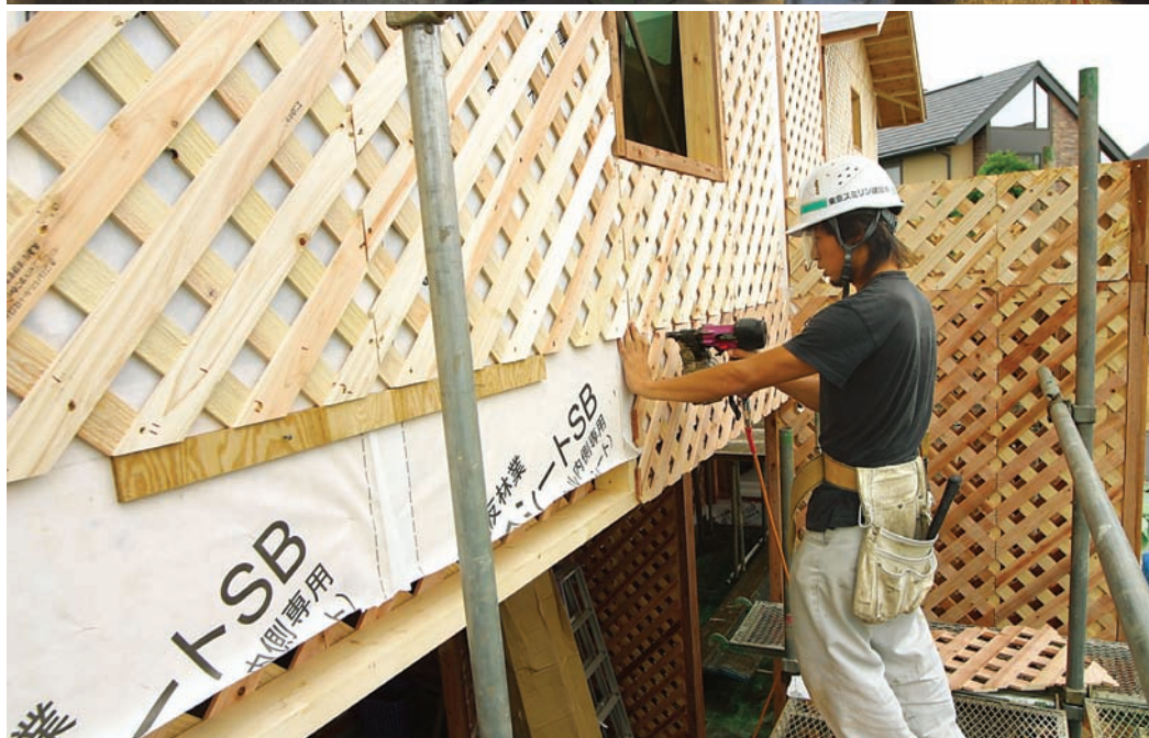
耐力壁として使われるクロスパネルはスギもしくはカラマツで製造される。同じ厚み（9mm）の構造用合板に比べや約 1.3 倍の剛性を有しながら、重量は 6、7 割程度と軽く、扱いやすい
