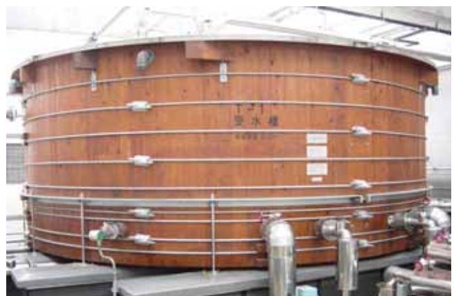
日本木槽木管株式会社によって県産材を用いて作られた埼玉県立武道館の木製受水槽
