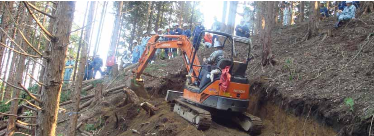
円滑に作業を行うために必須な作業路の整備（関東森林管理局管内での現地検討会の様子）
