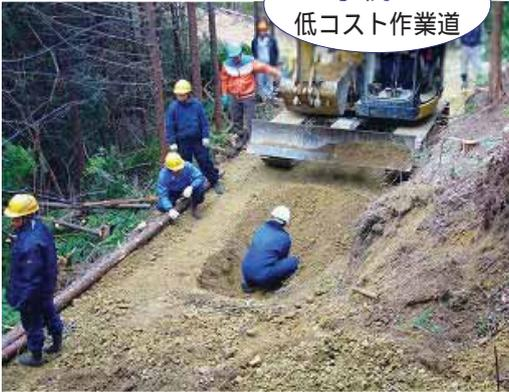
近畿中国森林管理局 和歌山森林管理署での低コスト作業道の開設。間伐などの森林整備を低コストで行うため、継続的に利用する作業道を整備
