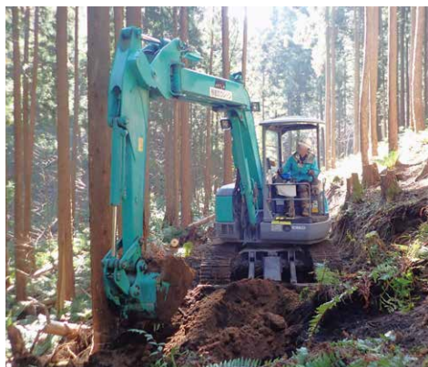
研修生による森林作業道の作設
