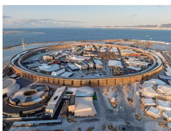
内周直径約616m、円周約2kmにわたる圧倒的なスケールの世界最大の木造建築物として、ギネス記録に認定。日本の伝統的な貫接合を採用し、「つくりやすく・解体しやすく・リユースしやすい」架構形式とした、環境負荷を低減する循環型建築。
