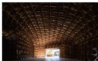
熊本県産の小国杉を使い材長4m以下の小中径製材が互いにもたれかかるように支え合う「木造レシプロカル構造」により、新しい木造無柱空間を実現。
