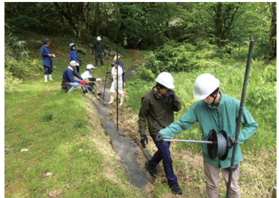
山中峠の湿原での電気柵設置作業
