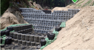
応急対策完了(珠洲市大谷町)
