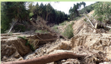
被災後(珠洲市大谷町)
