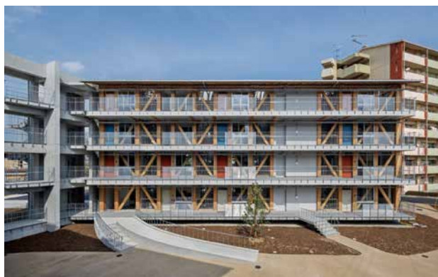
(写真2) 平成30年の建築基準法改正により可能となった長時間耐火構造による燃えしろ設計を用いた全国初の木造4階建て集合住宅(徳島県新浜町団地県営住宅2号棟) 出典: ウッドデザイン賞受賞作品データベース ( https://www.wooddesign.jp/db/production/1887/ )
