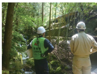
治山施設の点検
