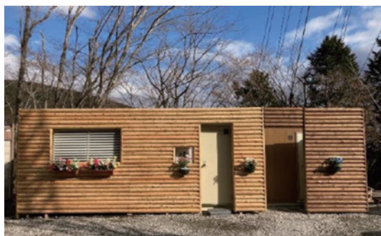
現場事務所に丸太を使用
