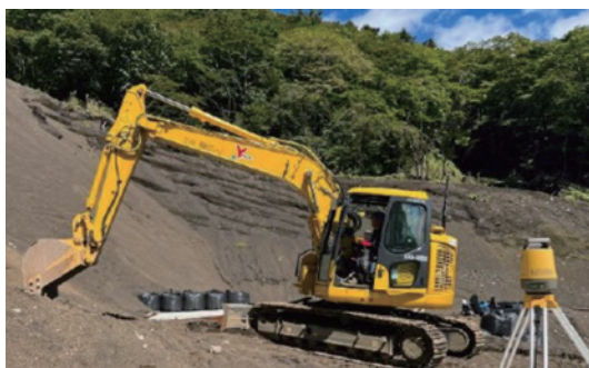
自動追尾式トータルステーションを活用したICT建設機械による施工
