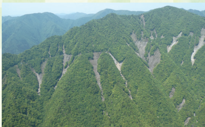
榛原川流域の復旧状況
