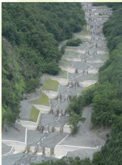
大井川流域の復旧状況(溪間工)
