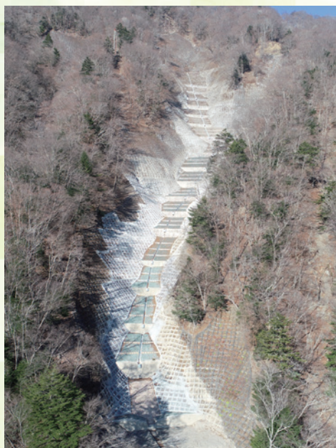
榛原川流域の復旧状況(山腹工)
