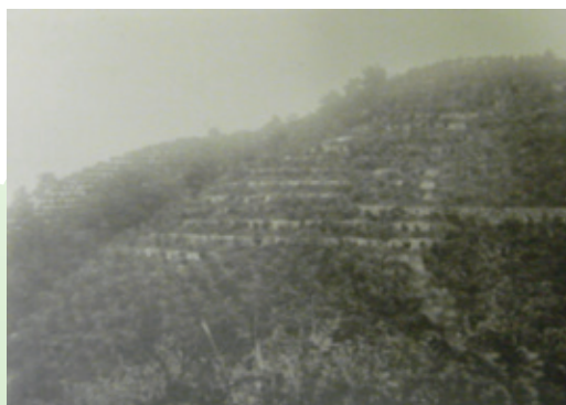
工事終了から5年後
