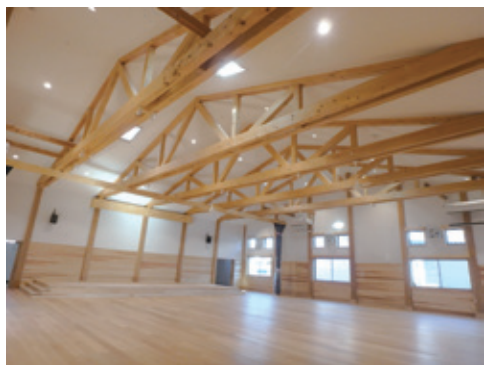
トラスにJAS構造材を利用して大空間を実現した保育園遊戯室棟 令和5年度支援事例：けやき保育園(栃木県栃木市) (延べ床面積572m 2 )
