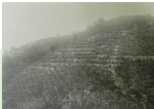
工事終了から5年後
