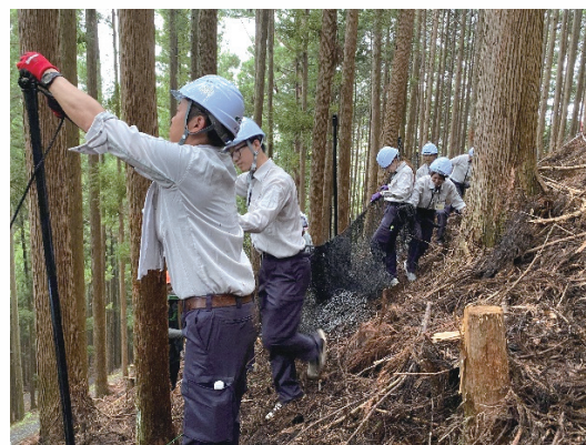
森を守る防鹿柵の設置
