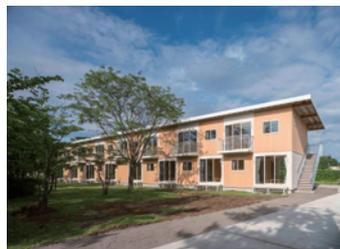
2024年1月1日に発生した能登半島地震の被災地に建設した木造による仮設住宅。DLTとよばれる、木材同士に木ダボを貫通させたパネルを、箱型にして千鳥に積むことで、短期間での建設を実現。
